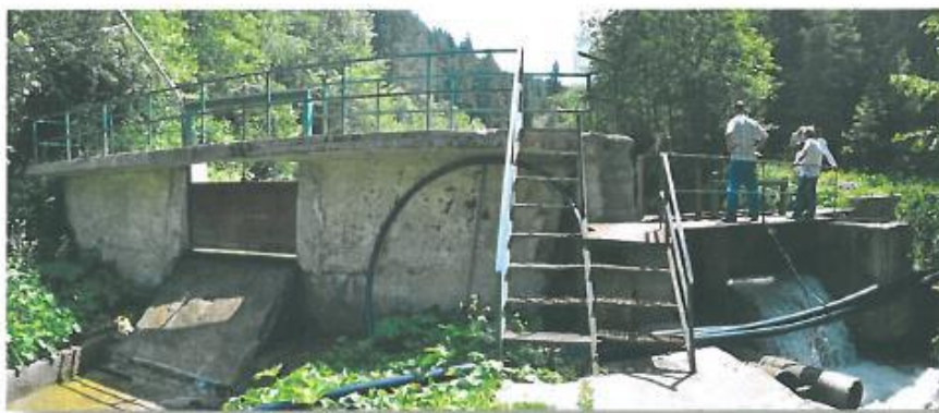
Figura 3.4-1: Vedere de ansamblu baraj Valea Azugii
