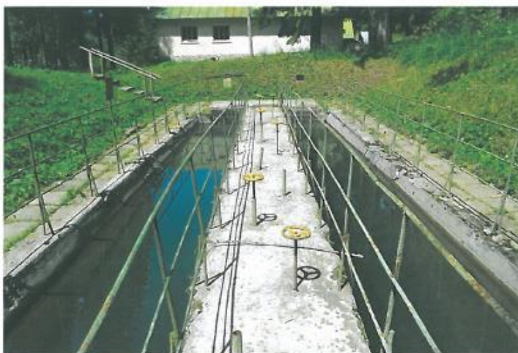
Figura 3.4-2: Vedere de ansamblu deznisipator
