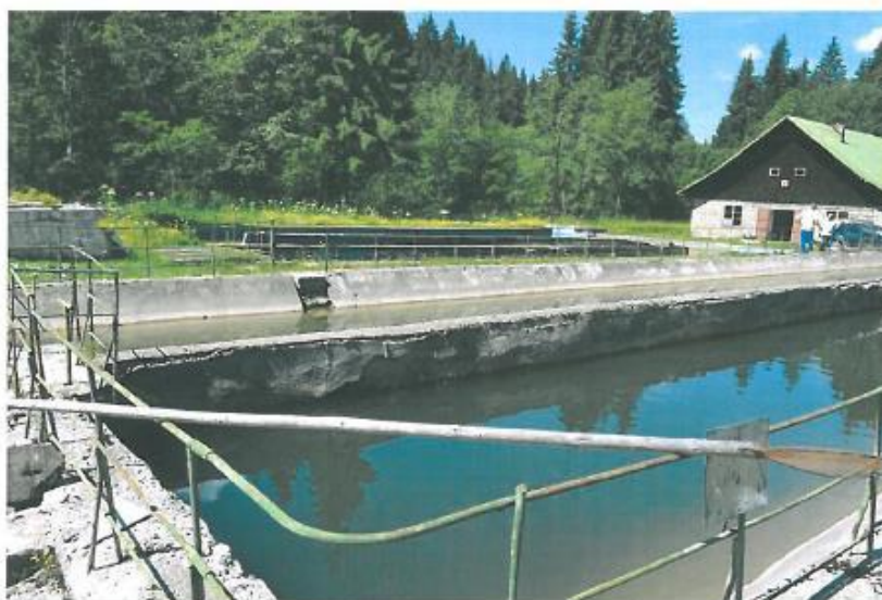
Figura 3.4-3: Vedere de ansamblu decantoare și stație de filtre
